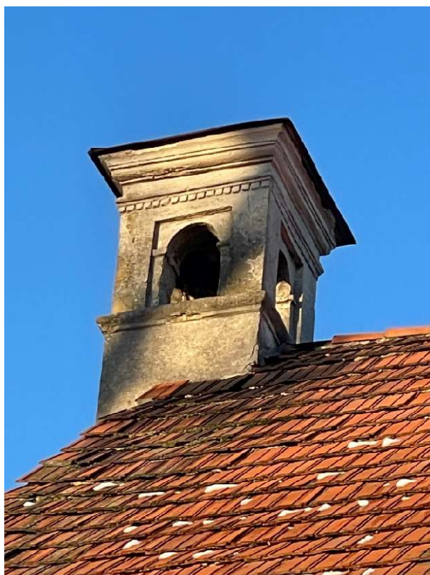
Widoczne pęknięcia tynku oraz zniszczenia dachówki
