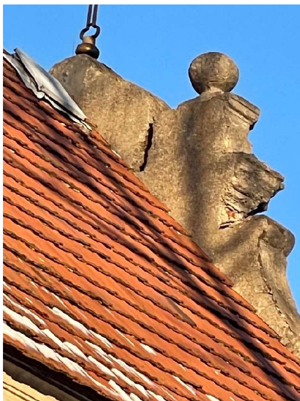
Widoczne pęknięcia i ubytki tynku
