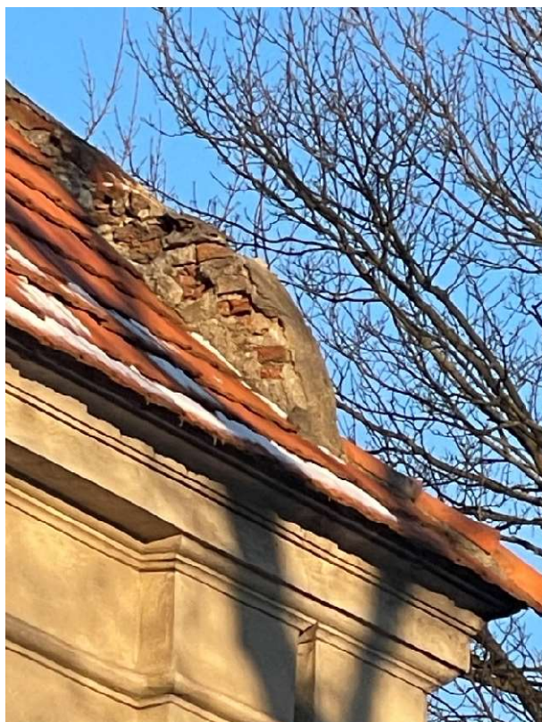
Widoczne pęknięcia i ubytki tynku
