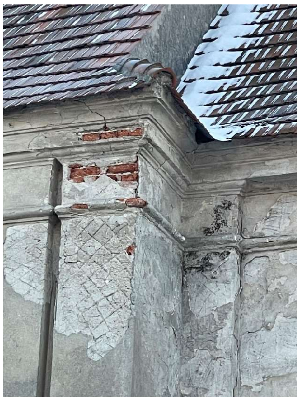
Widoczne zniszczenia spowodowane brakiem rynien i rur spustowych
