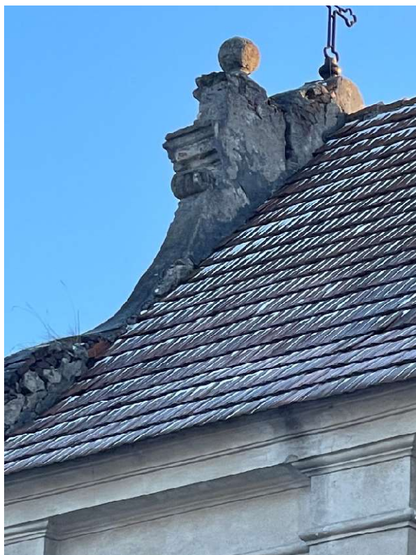
Widoczne pęknięcia i ubytki tynku
