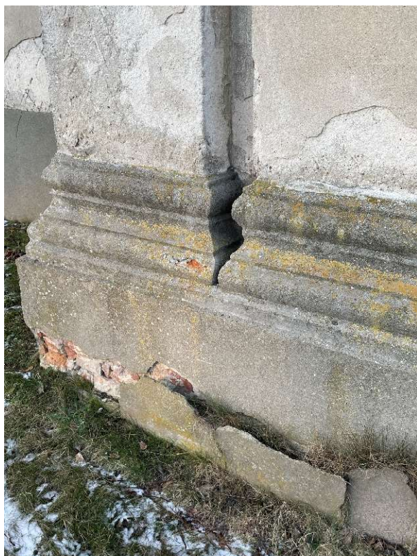
Widoczne odspojenia tynku
