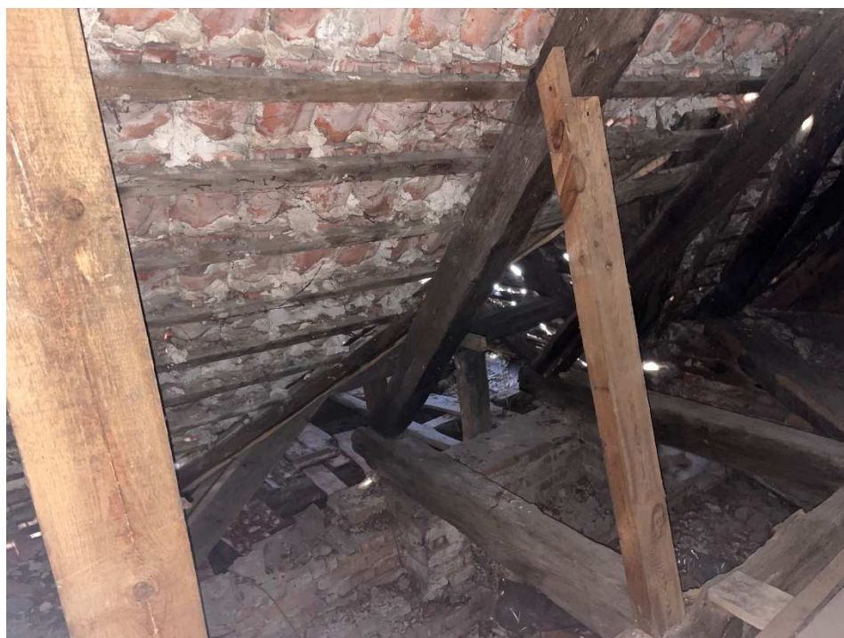
Istniejące wzmocnienie nadmiernie ugiętych krokiew
