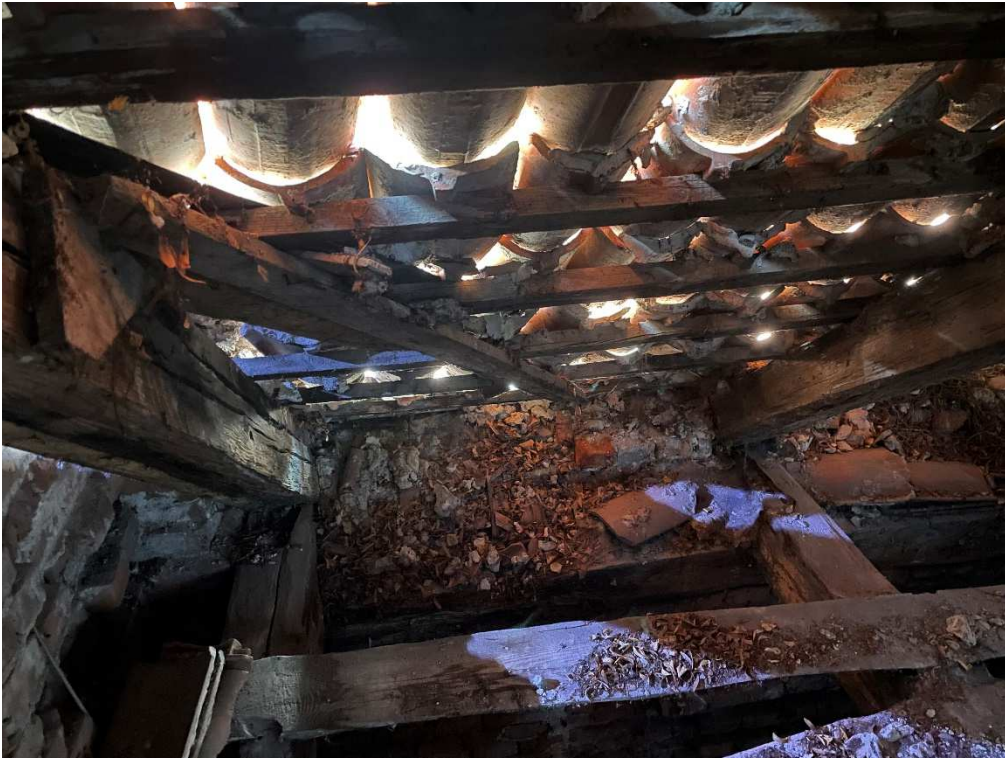
Uszkodzenia krokiew i uszkodzenia dachówek oraz wzmocnienia ugiętych łąt
