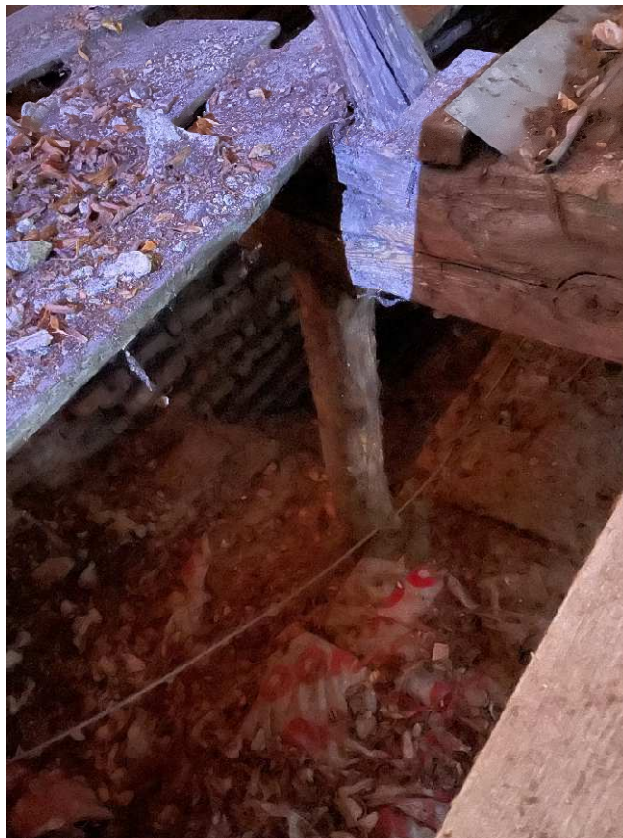
Istniejące wzmocnienia uszkodzonej belki podtrzymującej dach
